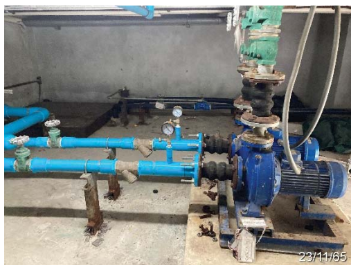
ปั๊มสูบน้ำขึ้นใต้ดิน
