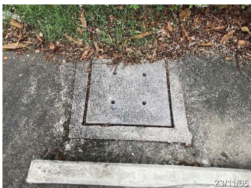
บ่อพักน้ำและท่อระบายน้ำนอกอาคาร
